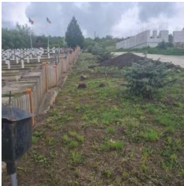
Fig.4 Soțul împrejmuirii perimetrare a cimitirului
